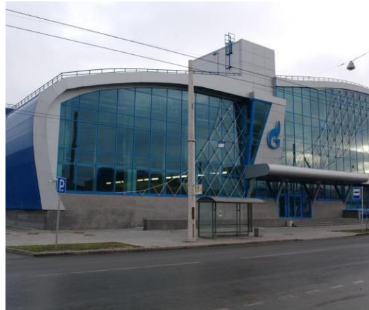
Мини-ТЭС для физкультурно- оздоровительного комплекса г. Санкт-Петербург Электрическая мощность: 1,0 МВт
