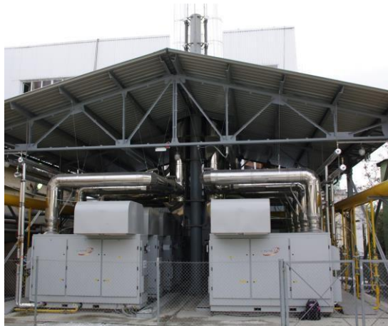
Энергоцентр для горнолыжного курорта Горнолыжный курорт «Игора», Ленинградская область Электрическая мощность: 2,32 МВт
