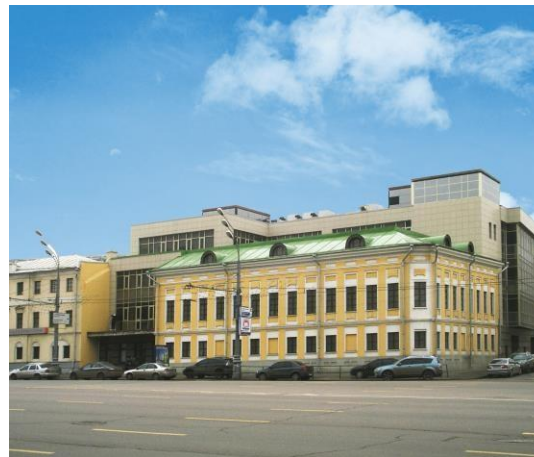
Энергоцентр для офисного центра г. Москва Электрическая мощность: 1 МВт
